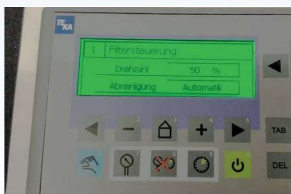
Mando de control integrado Siemens S7
